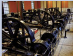
Das Wasserwerk am Hochablass dient heute nicht nur der Stromgewinnung. Es ist außerdem Trinkwasserinformationszentrum und Technikmuseum.
