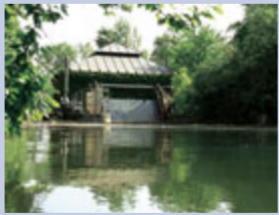
Gleich neben der Bundesagen-tur für Arbeit im Augsburger Stadtteil Oberhausen gewinnt das moderne Kleinwasserkraft-werk am Senkelbach Strom für 1800 Privatpersonen.
