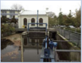
1892 errichtet, wurde das in den 1950er Jahren stillgelegte Wasser-kraftwerk in Goggingen im Jahr 2000 wieder aktiviert.
