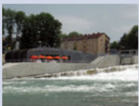
Gleichzeitig mit dem Kraftwerk im Augsburger Eisenbahner-wehr entstand ein neuartiger „Fischpass“.
