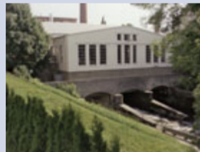
Seit 1865 arbeitet das Wasser-kraftwerk Riedinger. Die Zerstörung im Zweiten Weltkrieg hat den Betrieb des Kraftwerks nur unterbrechen können.
